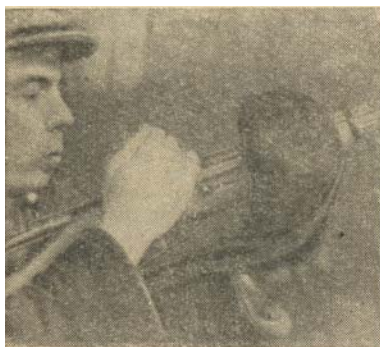
Рис. 360. Продувание ствола перед очередным прицеливанием для уменьшения «миража»
