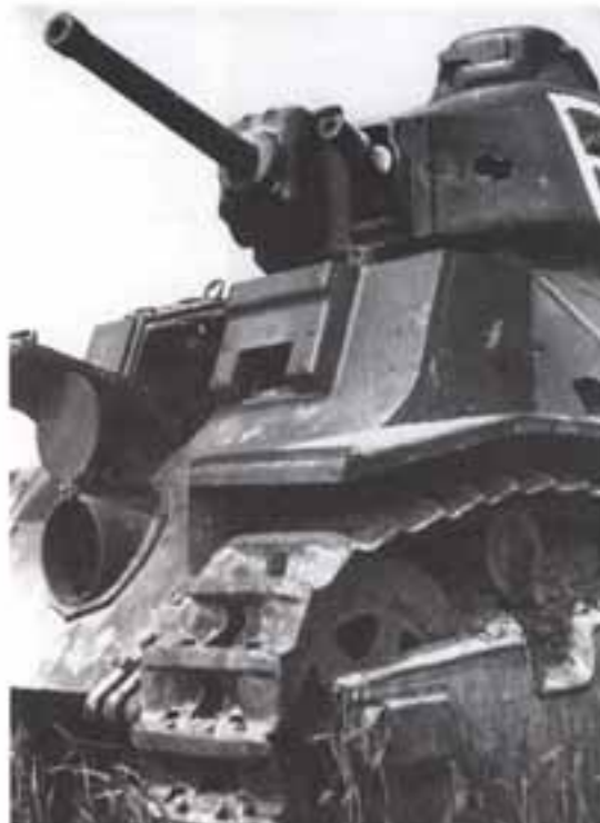
Еще один подбитый танк Т-34 из 343-й отдельной танковой роты. В броне башни отчетливо видны две сквозные пробоины, вероятно от 37-мм снарядов
