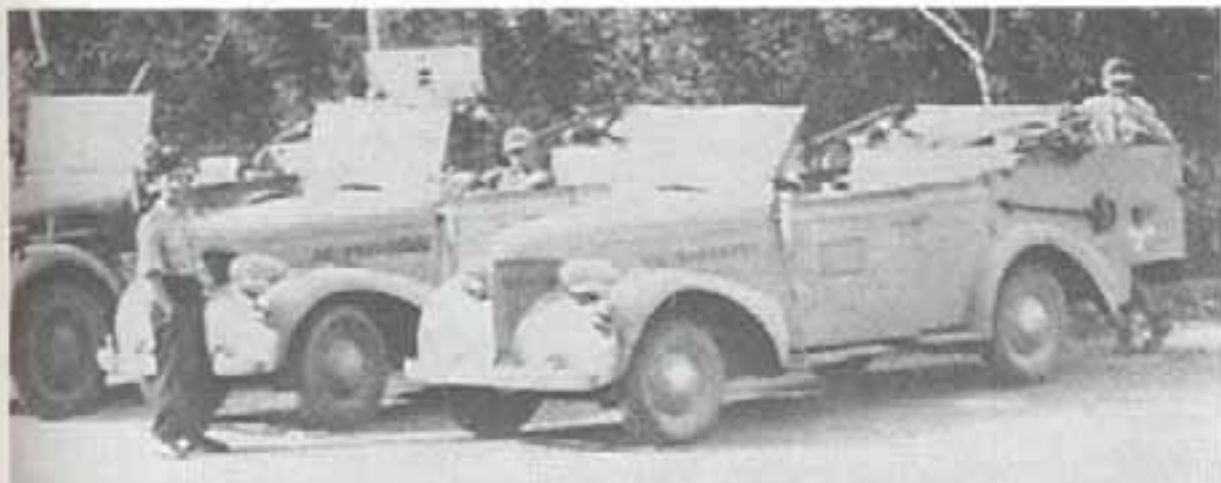
На Балканах, а также и в других местах трофейные четырехдверные лимузины (с кузовом седан) марки «Шевроле» (Chevrolet) были переоборудованы в открытые машины категории Kfz. 15 с ящиками для оборудования и продолжали использоваться на месте. На фото: Греция, 1945 г.
