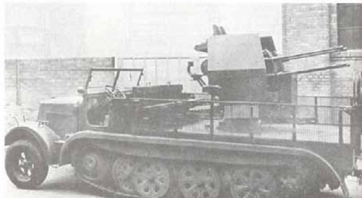
Четырехствольная ЗУ на тягаче 8 т (Sd Kfz 7/1) в своем первоначальном исполнении. При входе в действие переднее и заднее решетчатые ограждения откидываются вниз.
