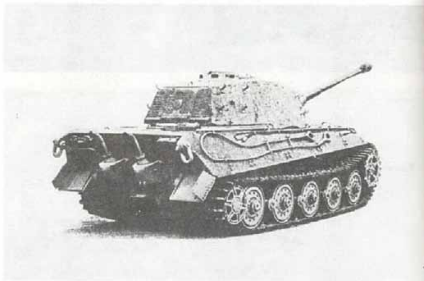
Танк «Королевский Тигр» («Тигр II» модификации В) с орудием KwK 43 L/71 и с башней производства фирмы «Хеншоль».
