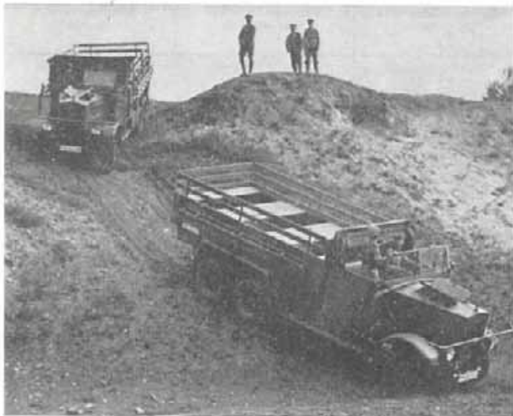
«Крупп» L 3 H 63 – средний грузовой автомобиль повышенной проходимости грузоподъемностью 3 т (1933–1935 гг.).
