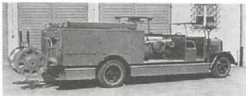
«Мерседес-Бенц» L 3750 с шестичилиндровым дизельным двигателем мощностью 100 л.с. в качестве рукавного тендерного автомобиля (кузов конструкции фирмы «Магирус») для люфтваффе. Серия 1938–39 гг. Показанный на снимке автомобиль был отправлен на авиационную базу в Липкейм.
