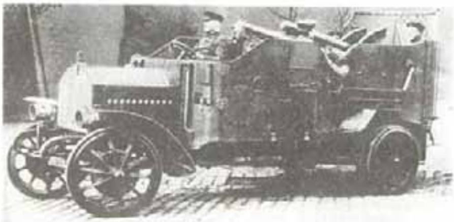
Автомобиль «Крупп-Даймлер» с орудием для поражения аэростатов и частично бронированный. Год изготовления 1911.
