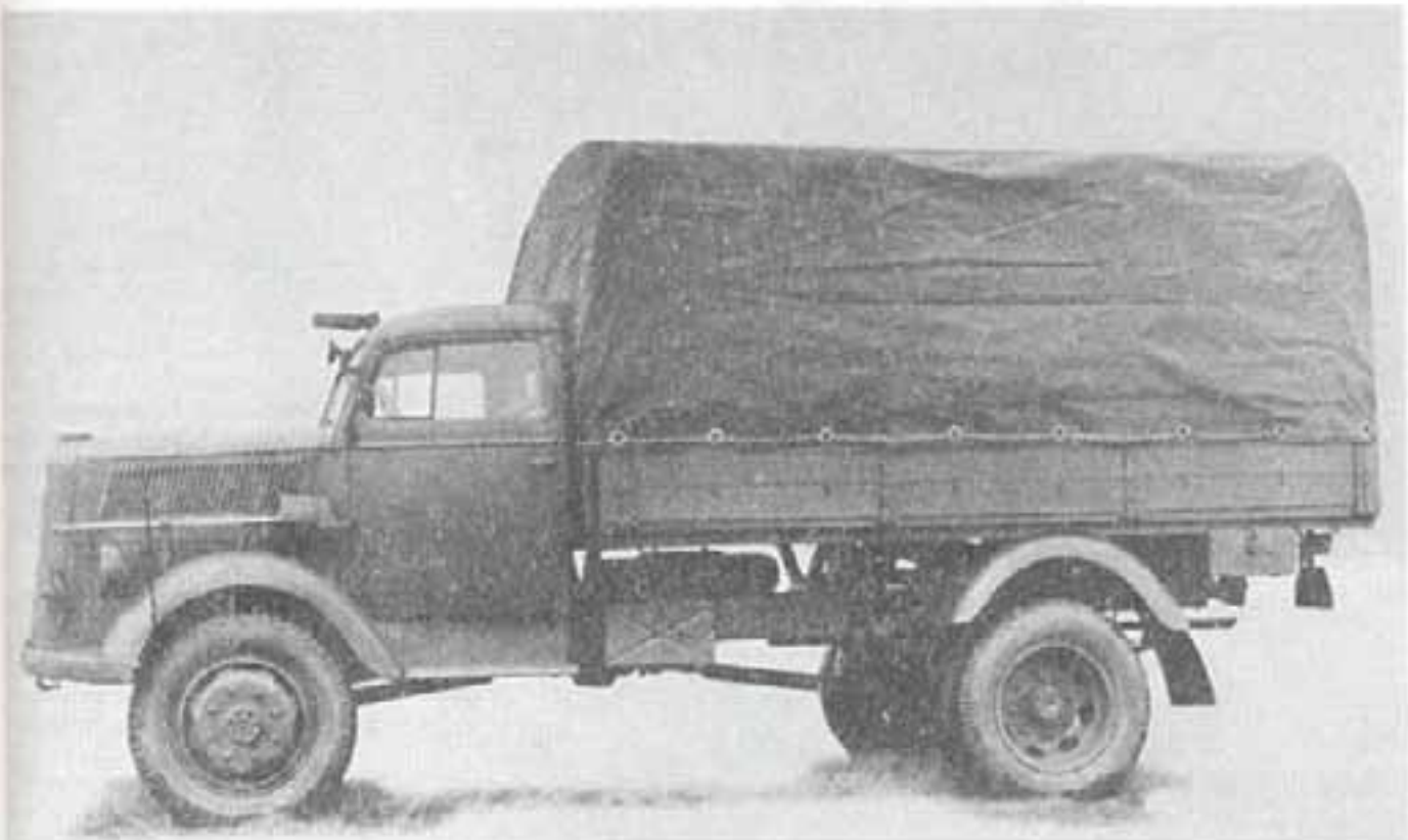
Тректорный «Опель-Блиц» А – полноприводный автомобиль с промежуточной передачей для пересеченной местности – не остался незамеченным. Кто хорошо знал пустыню, тот сразу высоко оценил эту модель за надежность и «бычий» внешний вид. «Опель» отличался высокой проходимостью, несмотря на сдвоенные колеса заднего моста. По статистике, вермахт использовал около 25 000 грузовиков этого типа.
