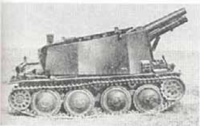
«Бизон» модификации Н, 150-мм тяжелое пехотное орудие на шасси Gw. 38 (t)
