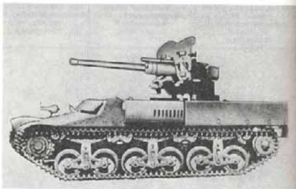
47-мм пушка 4,7cm Pak (f) на шасси тягача «Лорран» (Франция)
