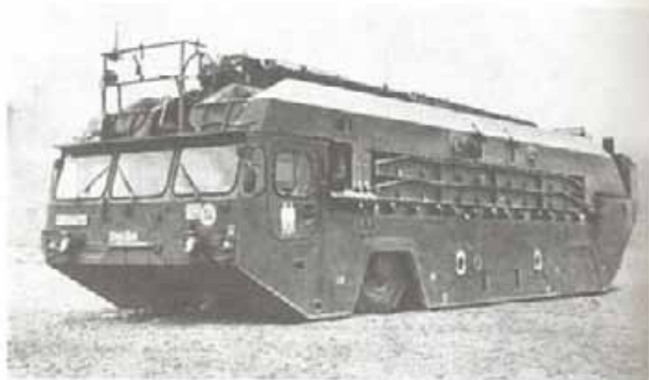
Автомобиль- амфибия модели М-2 для наводки мостов и переправ
