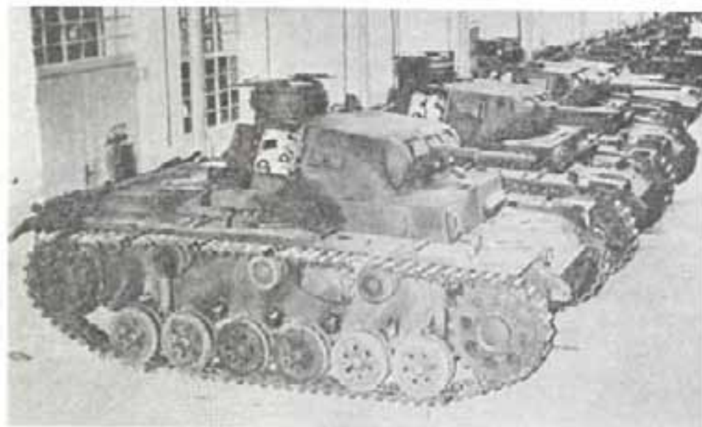
Танк Pz IIIE с башней танка модификации D. 37-мм орудие L/45 и 2 установленные в башню пулемета (готовые к поставке на заводе Берлин-Мариефельде фирмы «Даймлер-Бенц»).
