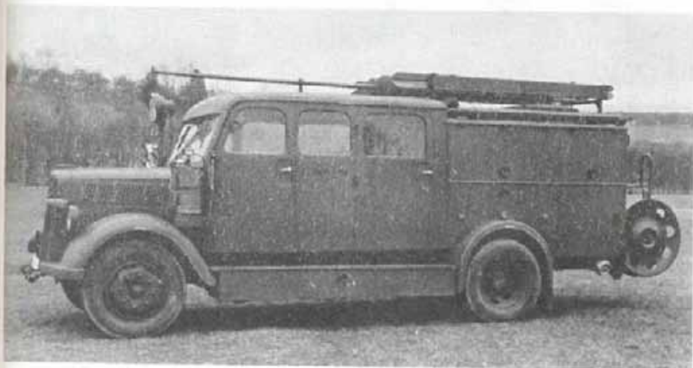
Трехтонка «Опель-Блиц» S в качестве пожарного автомобиля с мотонасосным агрегатом KS 15 (кузов фирмы «Магнус»), поставлявшийся в военно-воздушные силы в апреле 1941 г.
