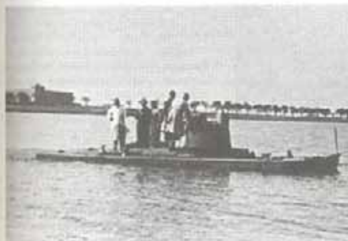
Танк Pz 38 (чешского производства), переоборудованный для операции «Морской лев» в плавучий танк, проходит испытания в 1942 г. на озере Зеефлингерхорст.
