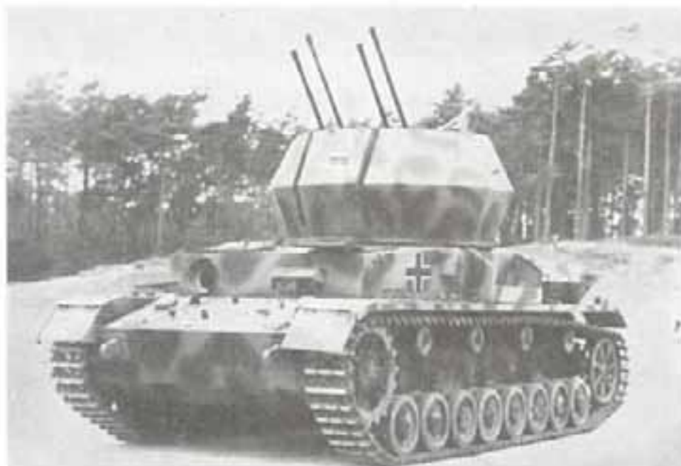
ЗСУ «Вирбельвинд» — на шасси танка Pz IV (20-мм четырехствольная установка)
