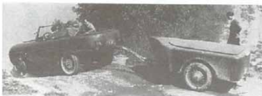
Автомобиль-амфибия «Триппель» SG 6 с плавучим прицепом. Наиболее важные характеристики SG 6: Двигатель «Опель» 6 цилиндров, рабочий объем 2,5 л, мощность 55 л.с., трехступенчатая коробка передач + ПрП, привод на четыре колеса, база 2489 мм, габаритные размеры 4 825 x 800 x 1910 мм, вес 1750 кг.
