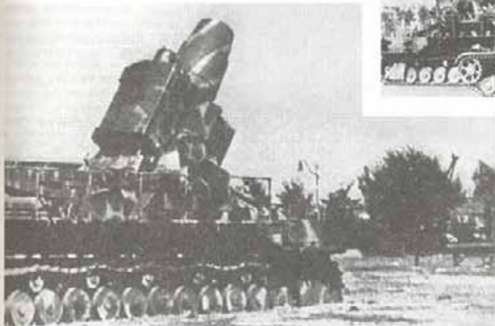
Мортира калибра 600 мм, называвшаяся также «Карл» или «Тор», на самоходном лафете с 8 (фото сверху) или с 11 катками (фото внизу). На нижней фотографии показано также, как огромное орудие после произведенного выстрела осело в грунт. Фото справа: для стрельбы снарядами, каждый из которых весил 2200 кг, требовался специально изготовленный на шасси танка Pz IV транспортер для перевозки боеприпасов с 2,5-тонным подъемным краном.
