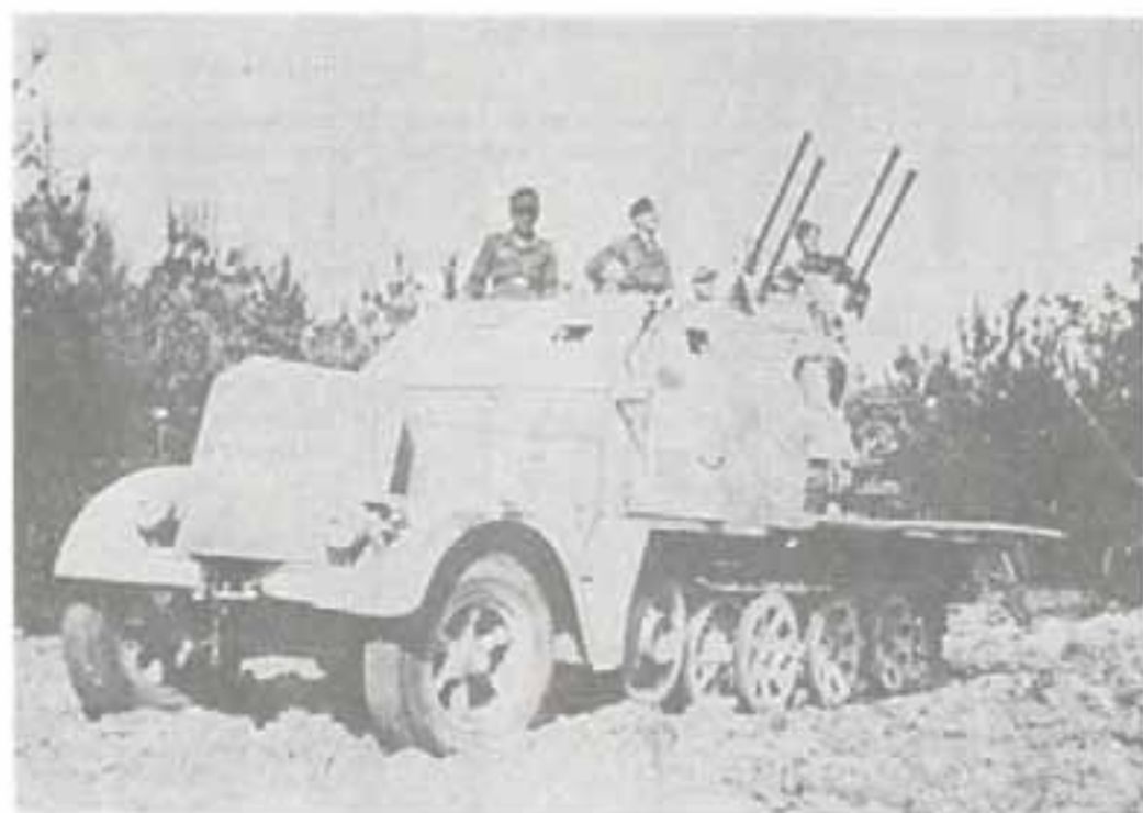
Самоходный лафет для 37-мм ЗП на тягаче 8 т (Sd Kfz 7/2). Окончательная конструкция с бронированной кабиной водителя, защитой радиатора и деревянной бортовой платформой.
