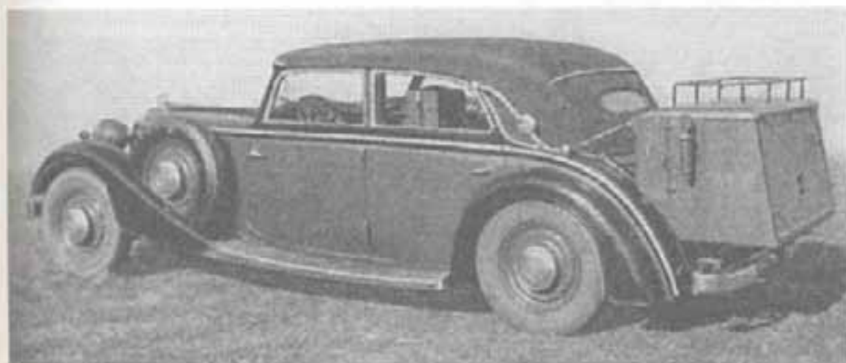
Четырехдверные кабриолеты «Хорх» 830 BL были переоборудованы под автомобили для радиосвязи категории Kfz. 15. Однако эти машины были постоянно перегружены и совершенно не приспособлены для движения по бездорожью.
