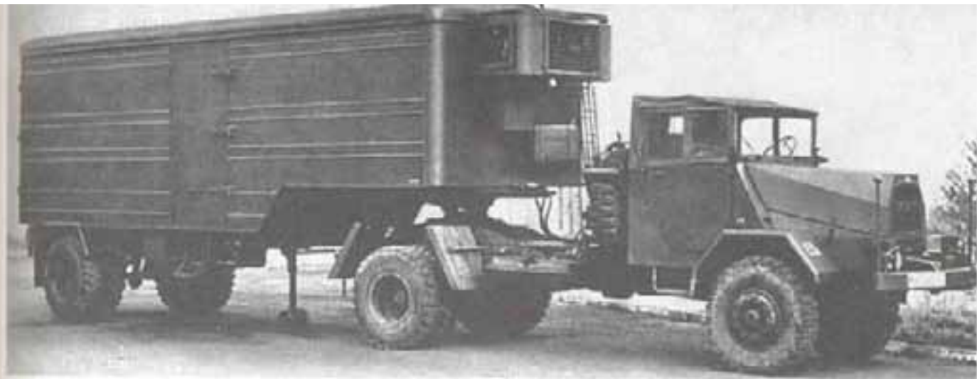
Седельный тягач повышенной проходимости 5 т MAN 630 L 2 A с кузовом-холодильником
