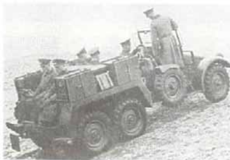
Эта важнейшая конструкция дала свое название «передку Крупп»: «Крупп» L2 H 43 и L2 H 143 как моторизованный передок артиллерийского орудия категории машин 69, предназначенный в качестве тягача для перевозки легких противотанковых или зенитных орудий.
