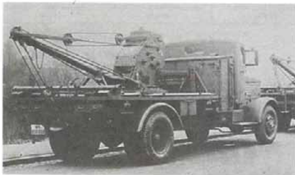
«Мерседес-Бенц» L 4500 S в качестве моторизованного разбрызгивателя KS 25 (кузов конструкции фирмы «Магирус»), серия выпуска 1941 г. для люфтваффе.
