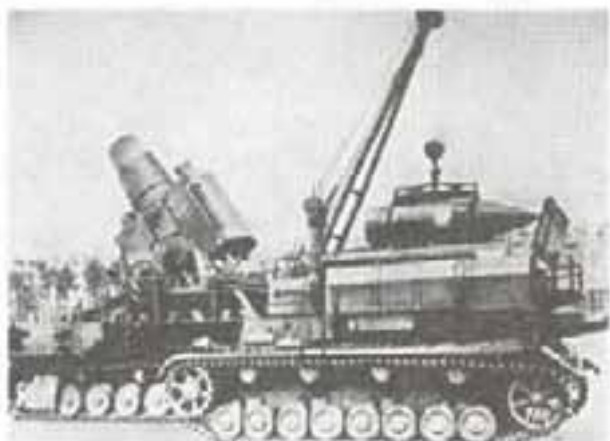
Мортира калибра 600 мм, называвшаяся также «Карл» или «Тор», на самоходном лафете с 8 (фото сверху) или с 11 катками (фото внизу). На нижней фотографии показано также, как огромное орудие после произведенного выстрела осело в грунт. Фото справа: для стрельбы снарядами, каждый из которых весил 2200 кг, требовался специально изготовленный на шасси танка Pz IV транспортер для перевозки боеприпасов с 2,5-тонным подъемным краном.
