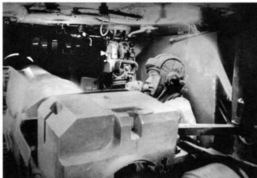
Интерьер самоходной установки СУ-152. На переднем плане — массивная казенная часть 152-мм пушки-гаубицы МЛ-20 с открытым поршневым затвором. За ней, на своем рабочем месте, — командир машины, перед посадочным люком которого установлена панорама ПТК-4. Курская дуга, 6 июля 1943 года
